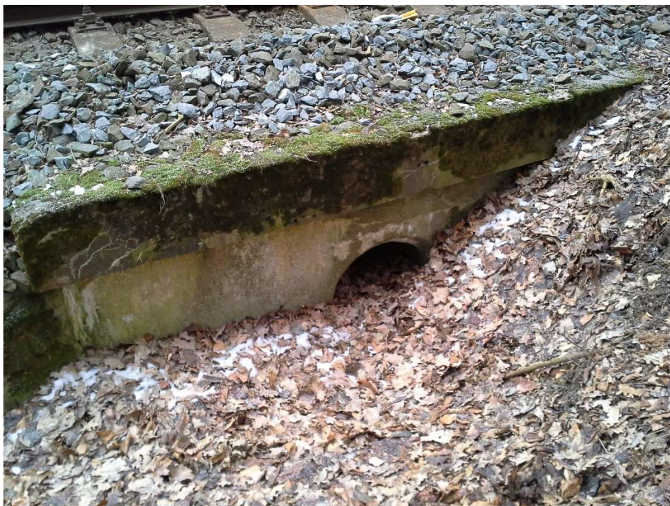
Foto 1: Pohled na zanesenou vtokovou stranu propustku
