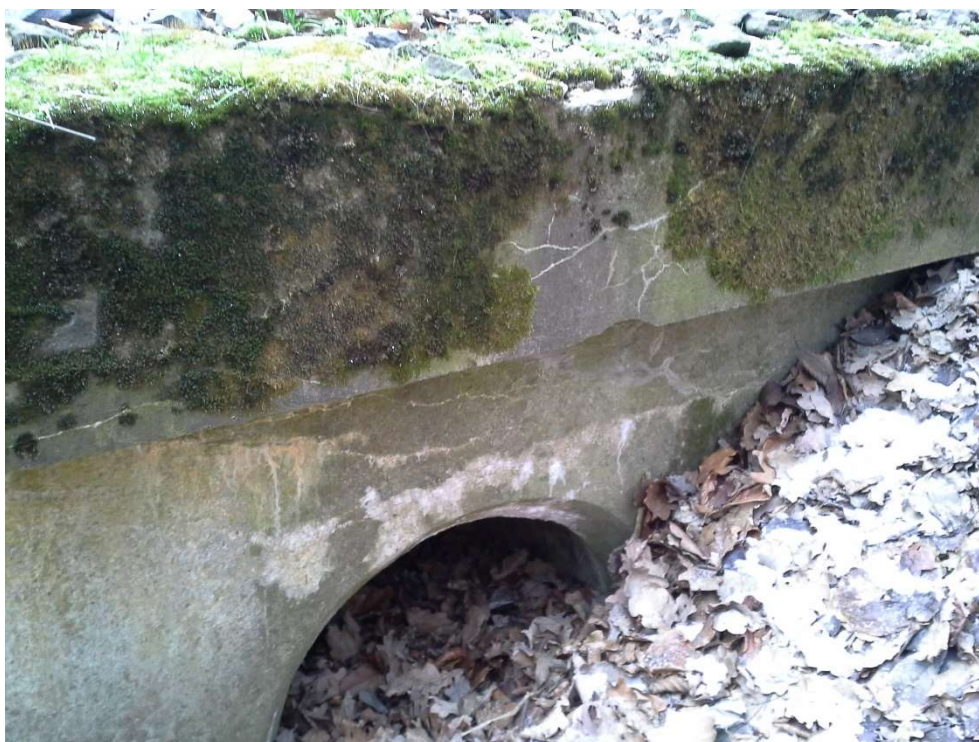
Foto 2: Detailní pohled na čelo a římsu se sítí trhlin a výluhů
