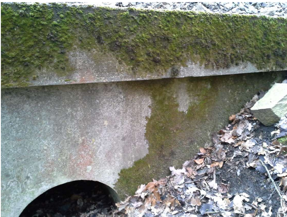
Foto 4: Detailní pohled na čelo a římsu propustku porostlou vegetací (mech)
