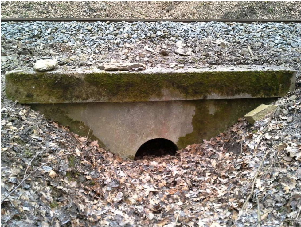
Foto 3: Pohled na zanesenou výtokovou stranu propustku
